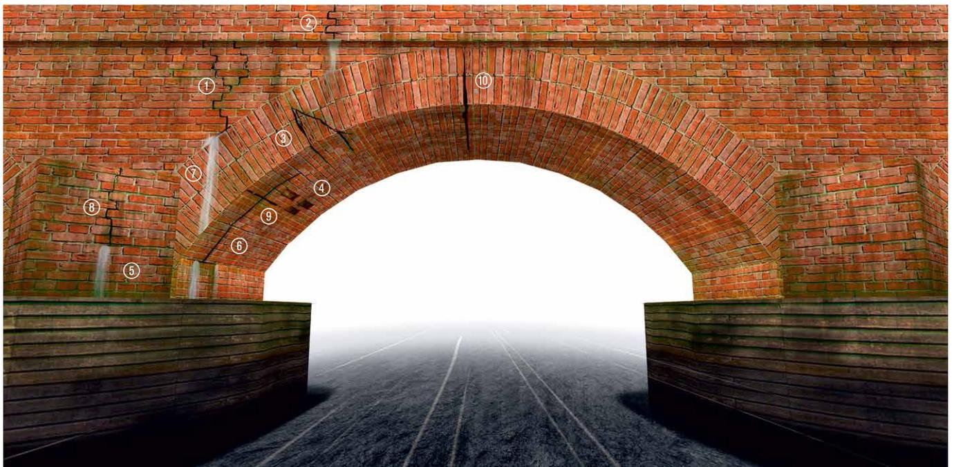
Besondere Aufmerksamkeit gilt dem fachgerechten Schließen von Rissen und Füllen von Hohlräumen, zum einen durch die Auswahl angepasster Füllstoffe / Injektionsgüter, zum anderen durch die Auswahl geeigneter Injektionsverfahren und Injektionstechnik.
