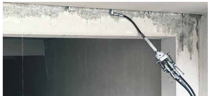
Injektion bauchemischer Füllstoffe | Injection of chemical filling material
